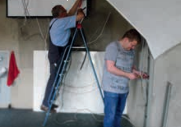
Abbruch, erst das Elektrische
